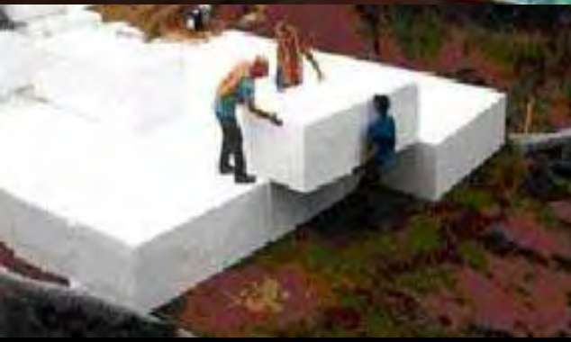
DPT Citra Green Dago dengan b-foam® Geof foam Solution
